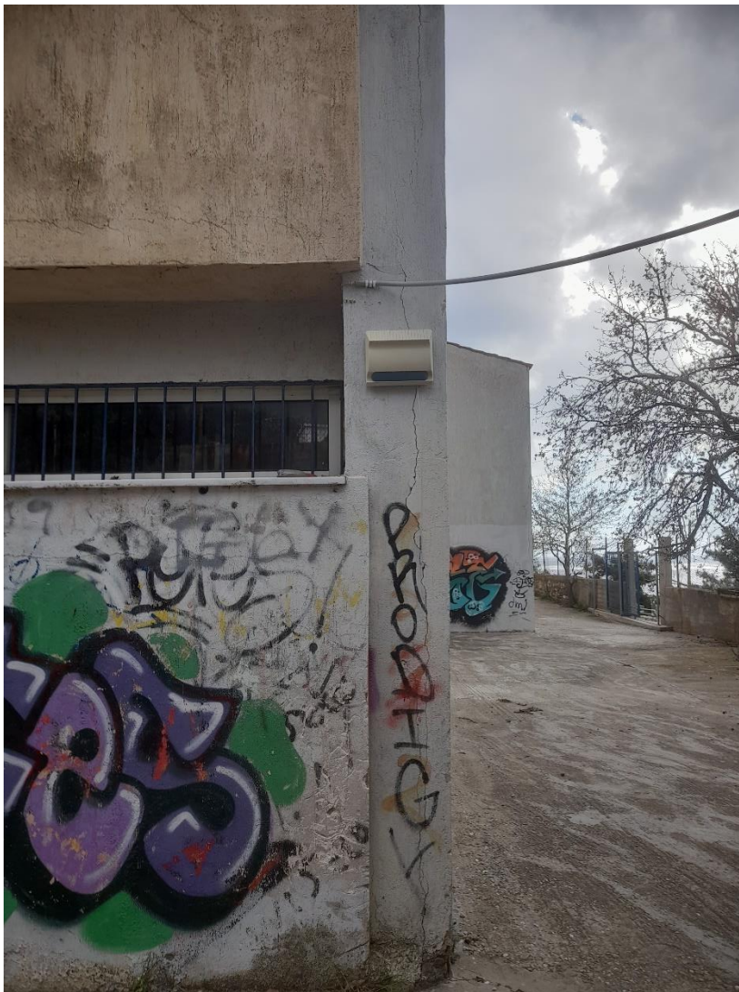
Κτίριο Γ βόρεια όψη
