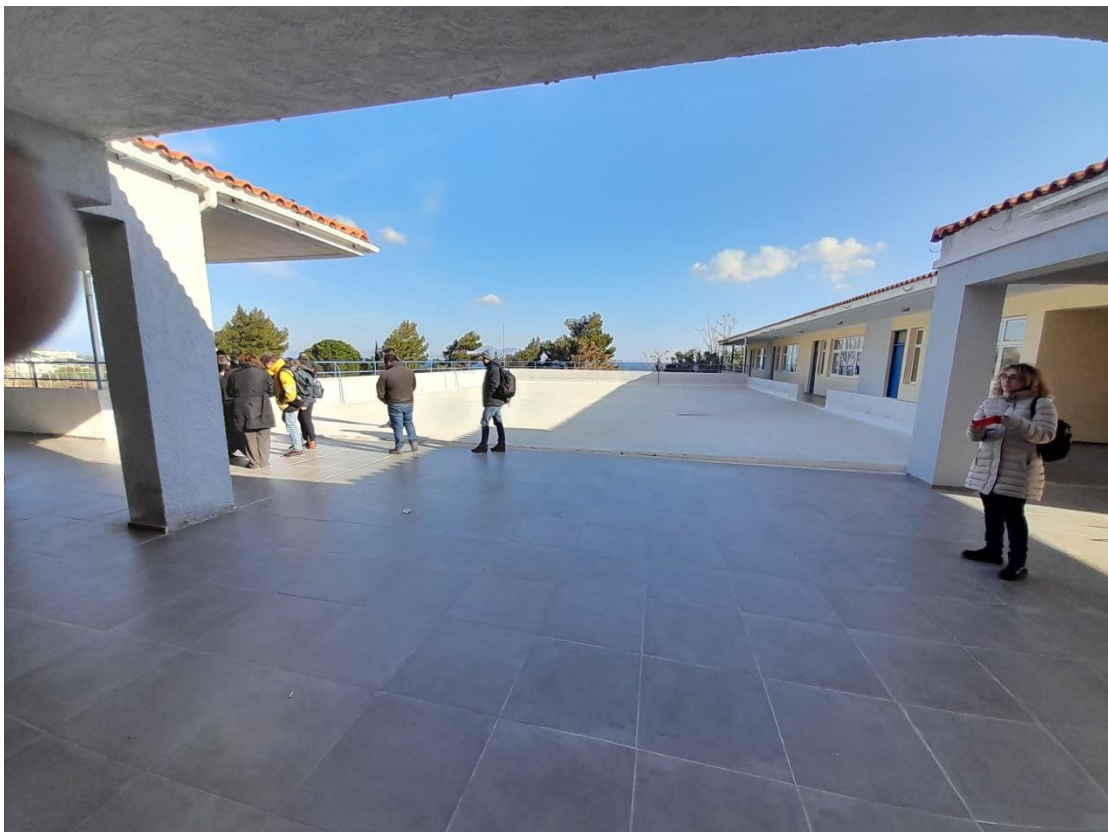
Γενική άποψη κτιριακού συγκροτήματος, στον όροφο
