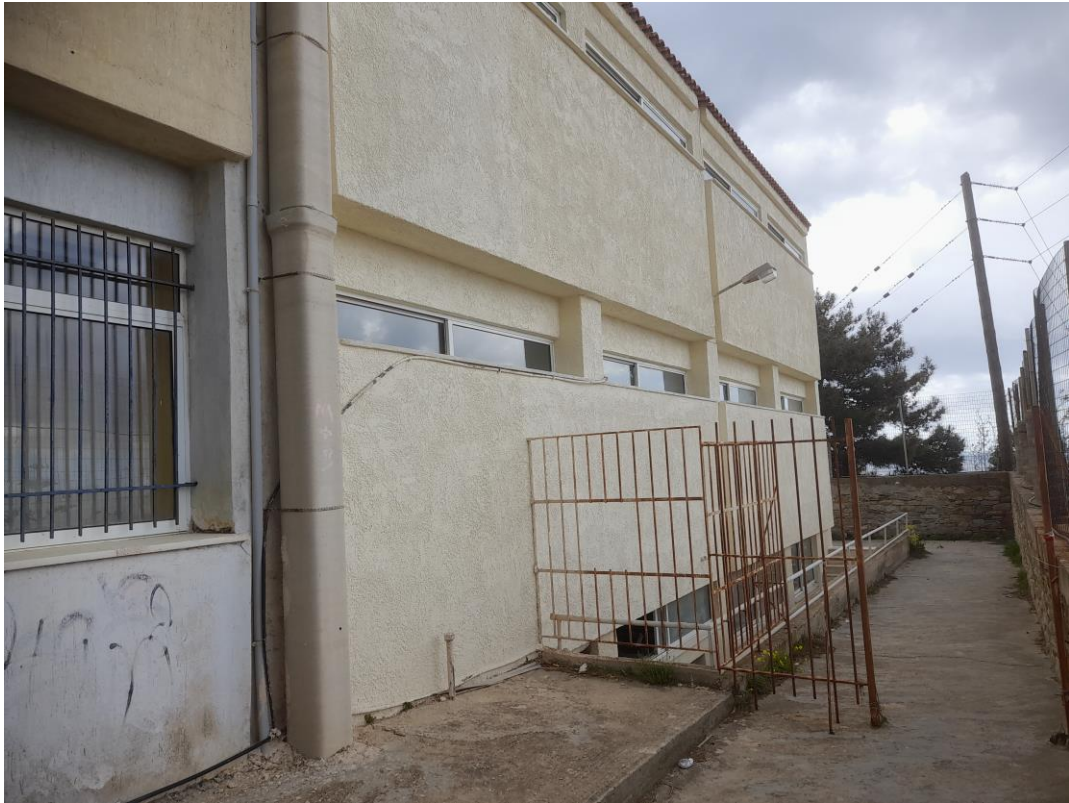
Κτίριο Α δυτική όψη (στον αρμό επαφής με το κτίριο Β) επισκευασμένη όψη
