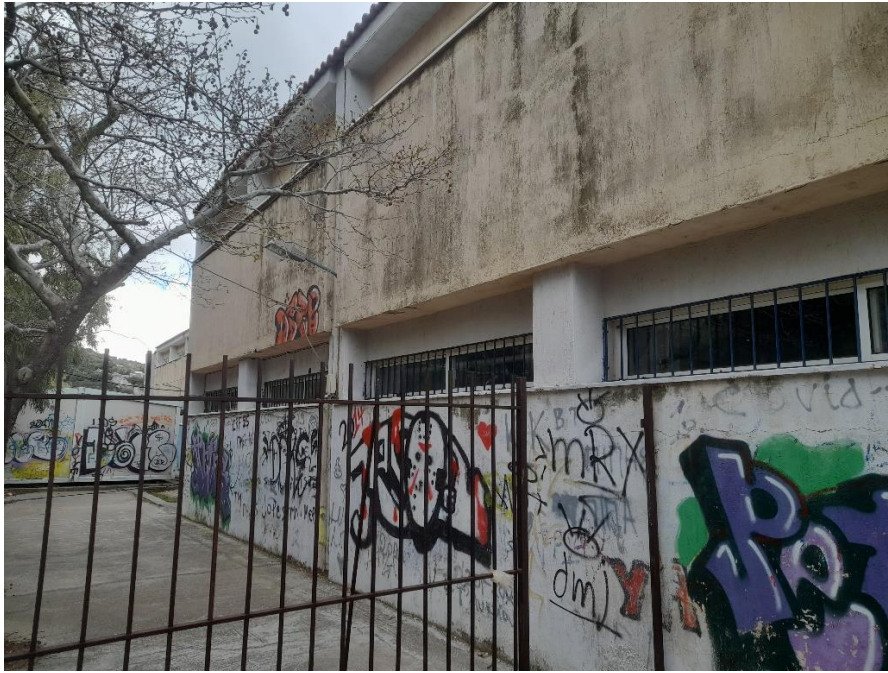
Κτίριο Γ βόρεια όψη
